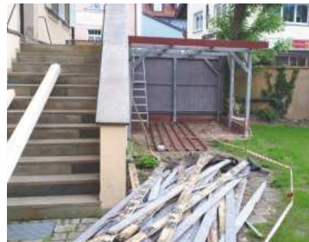
Material auf der Baustelle für den Unterstellplatz am Pfarrhaus
